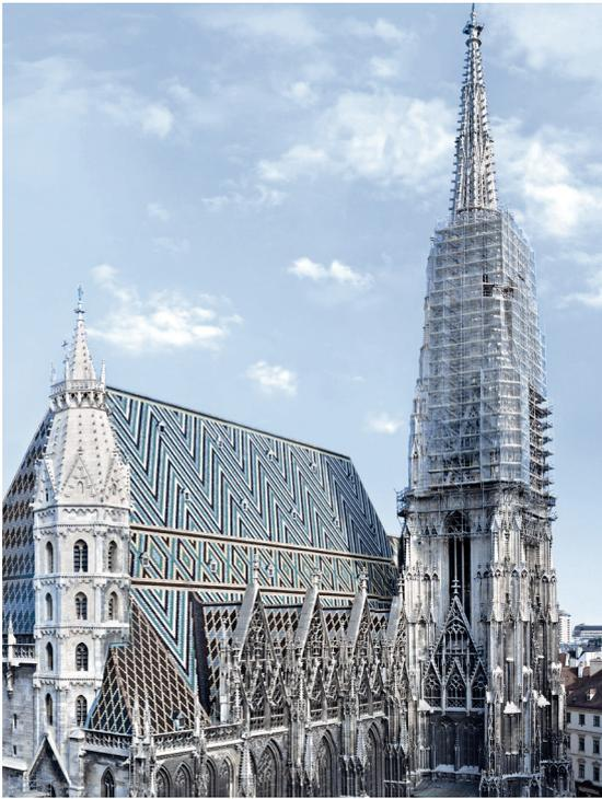
Bei der Einrüstung des Wiener Stephansdoms nutzen wir ein maßgeschneidertes Modulgerüstsystem, das ohne Verankerungen am Gebäude montiert wird
