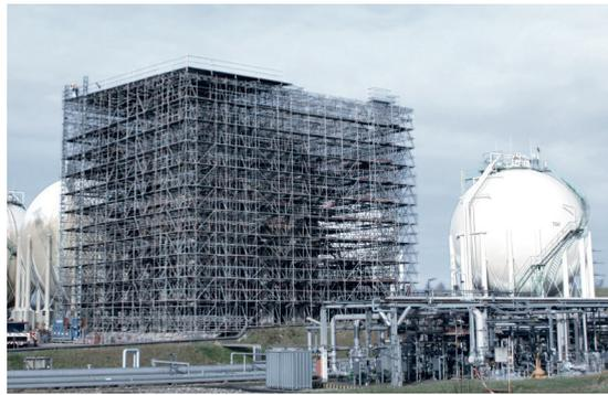
Auch im Rahmen der Instandsetzung von Kugeltanks erbringt XERVON logistische Spitzenleistungen und stellt enorme Mengen an Material bereit, um die riesigen Flächen mit Arbeits- und Schutzgerüsten auszustatten
