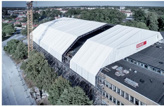
Spezielle Gerüstbaulösungen, wie z. B. dieses verfahrbare Wetzschuttdach für eine Gebäudesanierung in Schweden sind nur eine von vielen internationalen Herausforderungen, denen wir gewachsen sind
